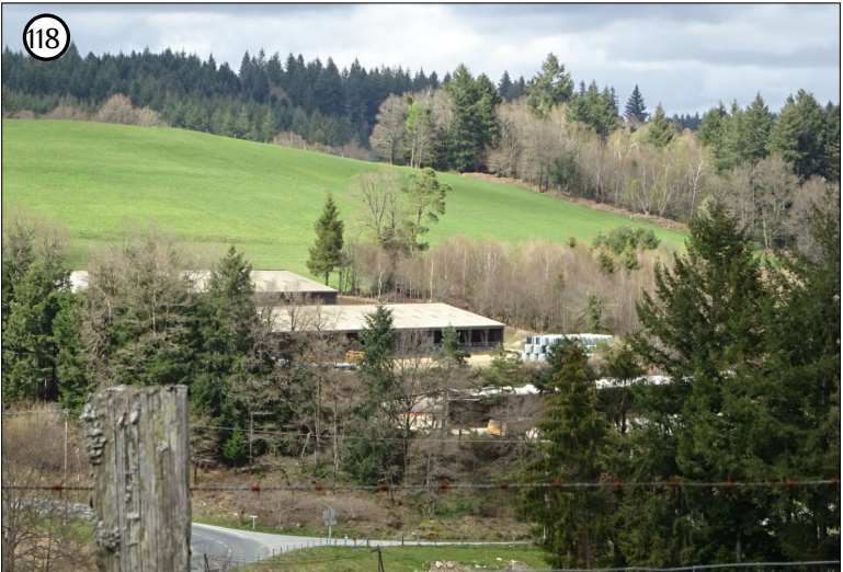
Vaste infrastructure agricole vouée à l'élevage bovin
